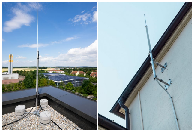
Isolierte Fangeinrichtung (Quelle: DEHN (links), OBO Bettermann (rechts))
