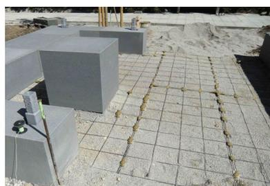
Bei Flächen kleiner 200 m<sup>2</sup> werden feinmaschige Metallgitter (Maschenweite maximal 0,25 m, Stabdurchmesser mindestens 3 mm) verwendet, die den Schutzraum an allen Seiten um 1 m überragen (Bild).
