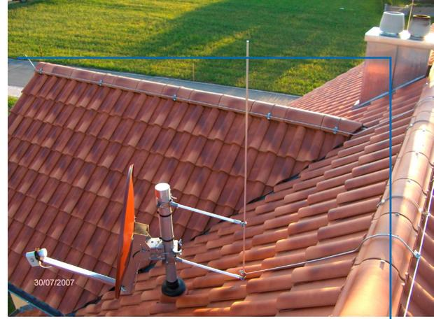
*Eine isolierte Fangstange schützt die SAT-Antenne.
