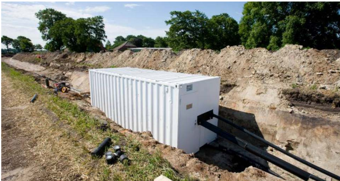
Abbildung 49: Einrichtung: Erstellung einer Muffenverbindung (VPE-HGÜ-Kabelsystem) [42]
