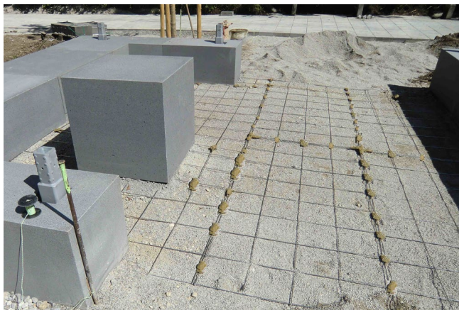
Bild 2: Potentialsteuerung für Schutzhütten (Foto, Prinzipgrafik) | Fritz Mauermann, Dehn
