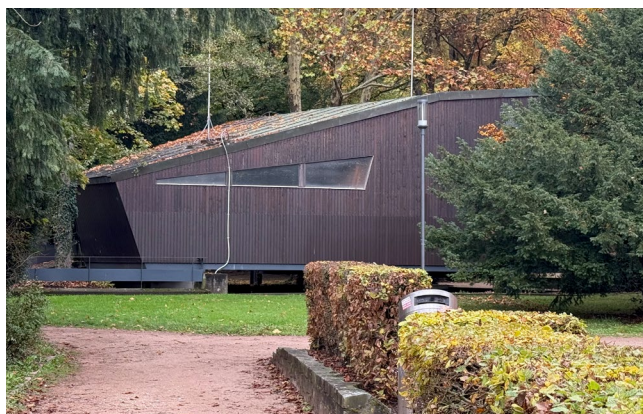
Bild 8: Bühne mit isolierter Ableitung | M. Rhein
