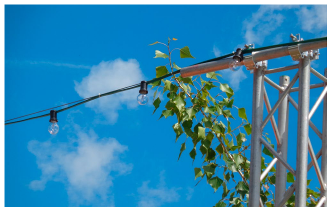
Bild 4: Lichterkette befestigt an einem Drahtseil | VDE
