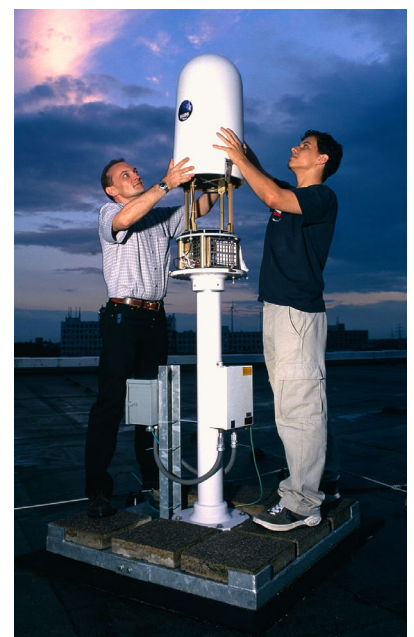
Bild 3: Blitz-Ortungssystem | Siemens BLIDS
