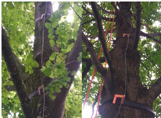
Bild 6: In einem Baum befestigte Fangeinrichtung und Ableitung | Wick Baumschnitt Baumpflege
