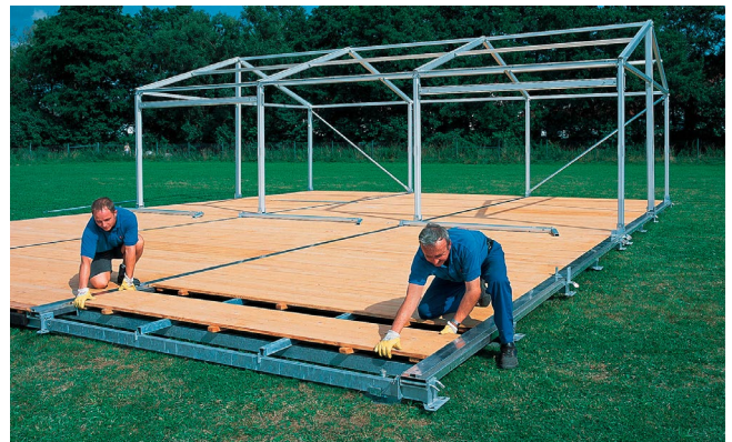
Bild 2: Zeltbau mit Kassettenboden | Röder Zelt- und Veranstaltungsservice
