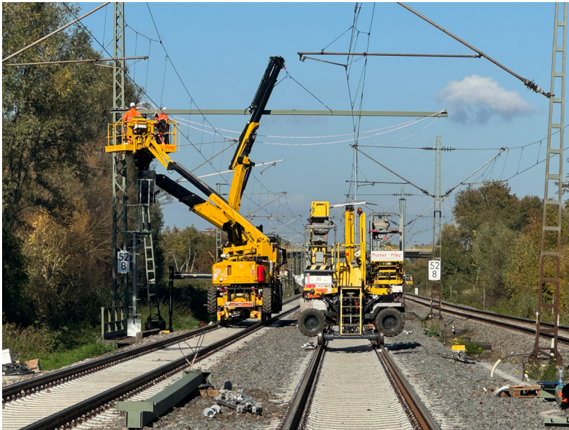
Abbildung 7: Arbeiten an der Oberleitung – Foto: Furrer+Frey
