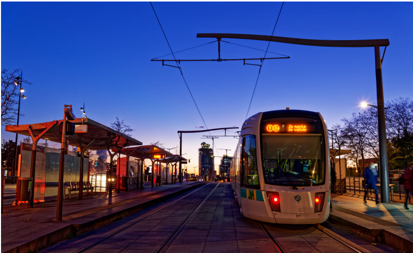
Abbildung 5 : Fahrleitung kann auch eine Chance für gelungene Stadtarchitektur sein – ein gutes Gesamtkonzept zahlt sich aus. Straßenbahnlinie T3 in Paris – Foto: Torsten Giesen
