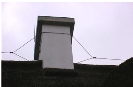
Bild 11: Leitungsführung am Kamin
