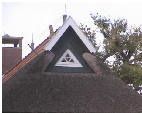
Bild 8: Reetdach mit Ziegelfirst
