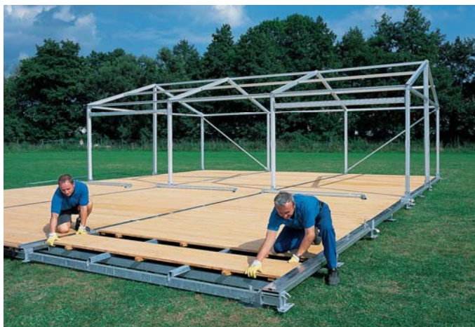
Bild 10: Zeltkonstruktion mit Stahlunterbauboden
